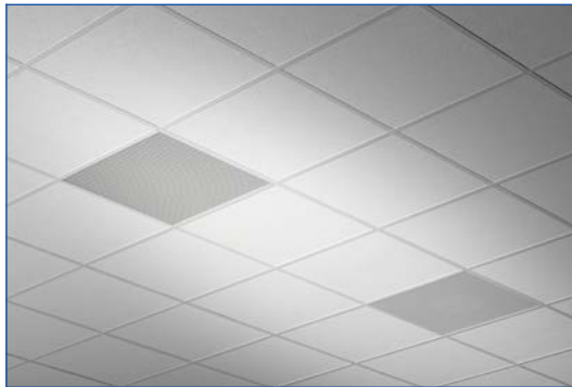
Inbouw in T-profiel systeemplafond, plaatsing in rijen
